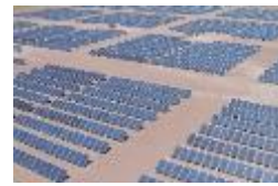
Springerville Fixed PV 5.1 MW
