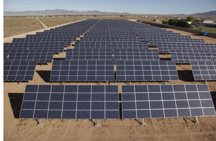
La Senita Solar Solar Project 1.2 MW
